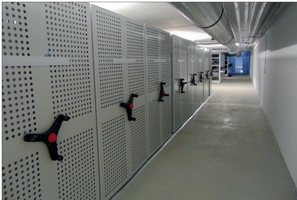
Ryc. 7. Regaly jezdne zamontowane w ramach realizacji zadania pn. Wyposażenie magazynu muzealnego zabytków archeologicznych MAH w Stargardzie . Fot. A. Bierca, MAH w Stargardzie
